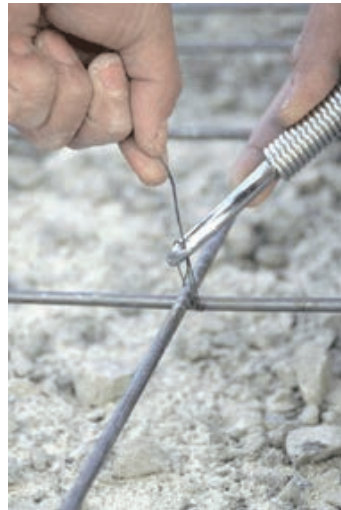
② ハッカーに結束線を掛け、輪を作る。
