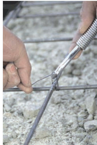
③ 左手を左下に下げ、結束線をハッカーにしっかりと絡める。
