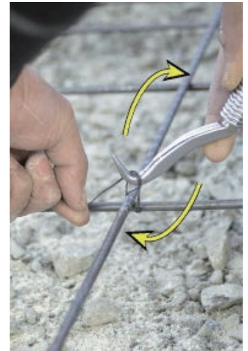
④ ハッカーを時計回りに回転させる。
