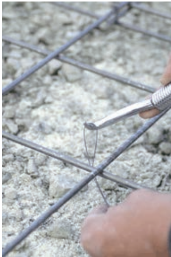
① 交差する鉄筋に結束線を引っ掛ける。
