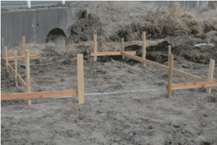
貫板が打ち終わった状態
